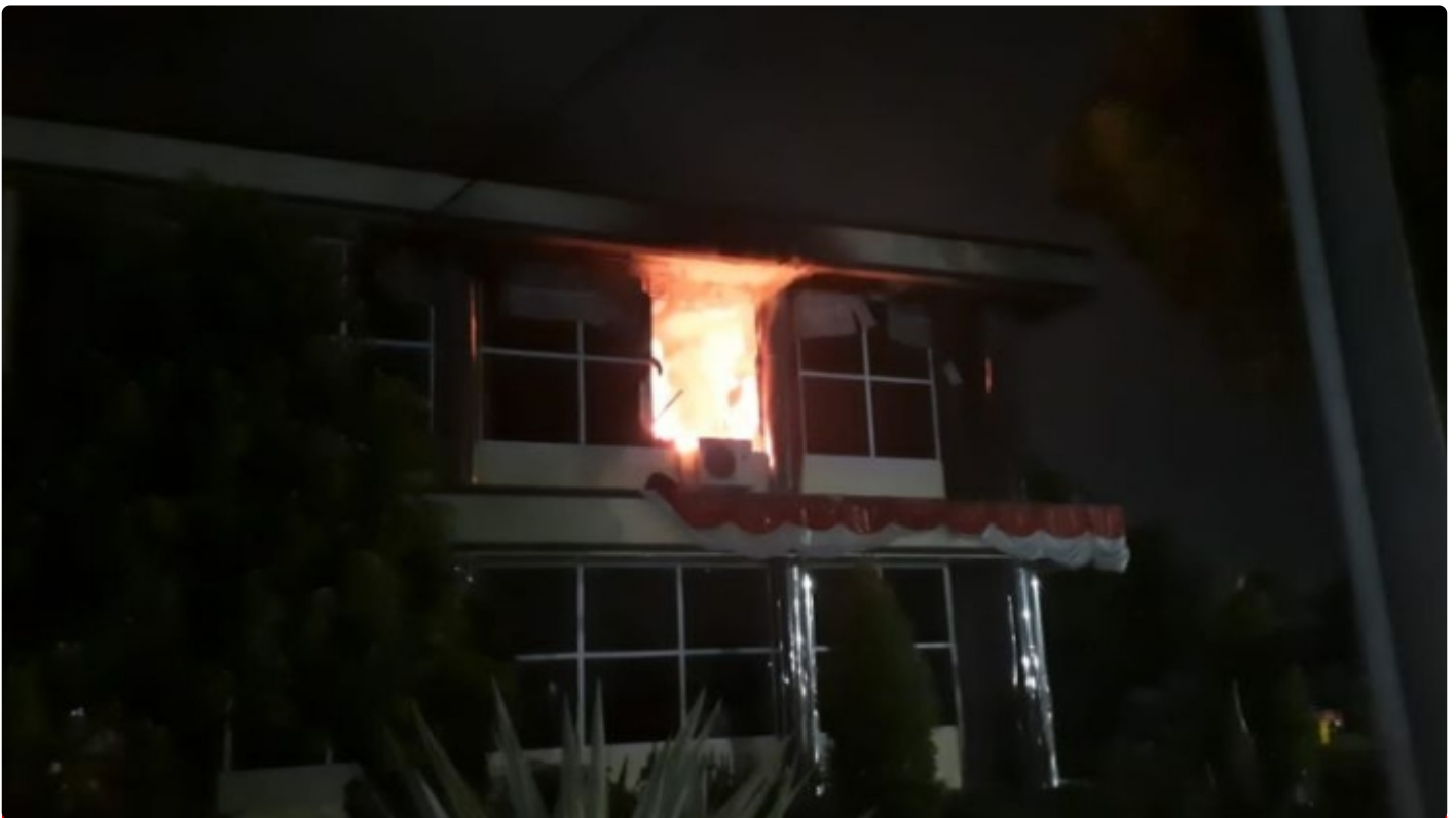
Diduga arus pendek, Gedung Ditreskrimsus Poldasu Terbakar, Kamis (25/8).
